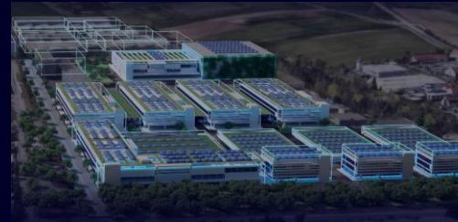
Neuer Technologie Campus Erlangen, Erweiterung von Entwicklungs- & Produktionskapazitäten (Digital Industries)
