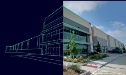
Neue High-Tech Produktionsstätte in Dallas-Fort Worth, Texas (Smart Infrastructure)
