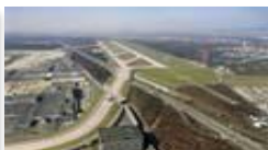
| 2011 Inbetriebnahme Landebahn Nordwest
