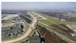
| 2011 Inbetriebnahme Landebahn Nordwest
